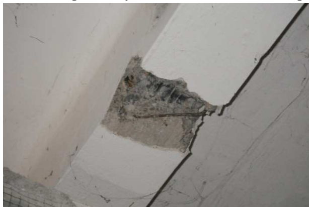
Foto č. 3 a 4 - sonda NV 3 – dutiny mezi žebírky – patrné přesazení forem ve styčích
