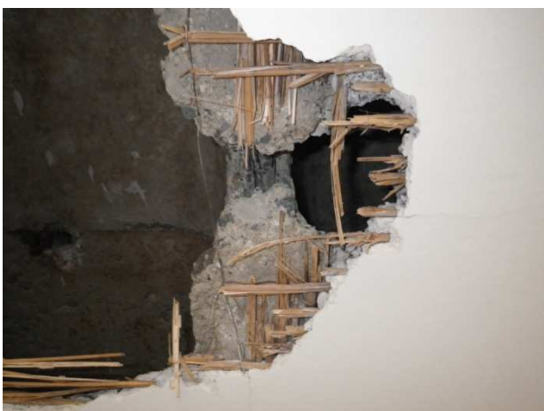
Foto č. 5 - 7 - sonda NV 5 – žebírkový strop, na snímcích patrná výztuž žebírka, rozšíření spodní pásnice žebírka, armování lehčeného betonu rákosovým pletivem a tvar dutiny stropu
