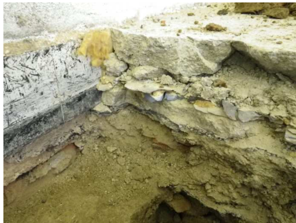
Foto č. 14 – 15 – kopaná sonda K 1 – patrný tvar základu, detail skladby podlahy
