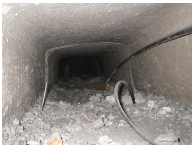
Foto č. 3 a 4 - sonda NV 3 – dutiny mezi žebírky – patrné přesazení forem ve styčích
