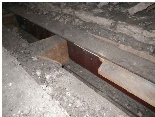
Foto č. 11 - 13 - sonda NV 13 – dřevěný trámový strop do I nosníků, na snímcích patrný I nosník opatřený ochranným nátěrem, na spodní pásnici uložen na výřez dřevěný trám, dutina mezi stropními trámy
