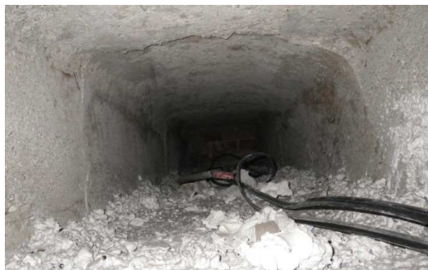
Foto č. 8 - 10 - sonda NV 7 – žebírkový strop, na snímcích patrná výztuž žebírka, rozšíření spodní pásnice žebírka, armování lehčeného betonu rákosovým pletivem a tvar dutiny stropu
