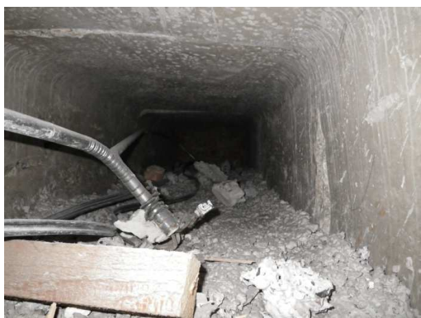
Foto č. 5 - 7 - sonda NV 5 – žebírkový strop, na snímcích patrná výztuž žebírka, rozšíření spodní pásnice žebírka, armování lehčeného betonu rákosovým pletivem a tvar dutiny stropu
