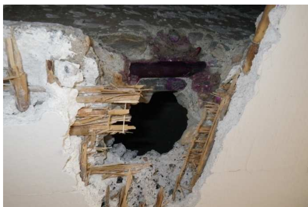
Foto č. 3 a 4 - sonda NV 3 – dutiny mezi žebírky – patrné přesazení forem ve styčích
