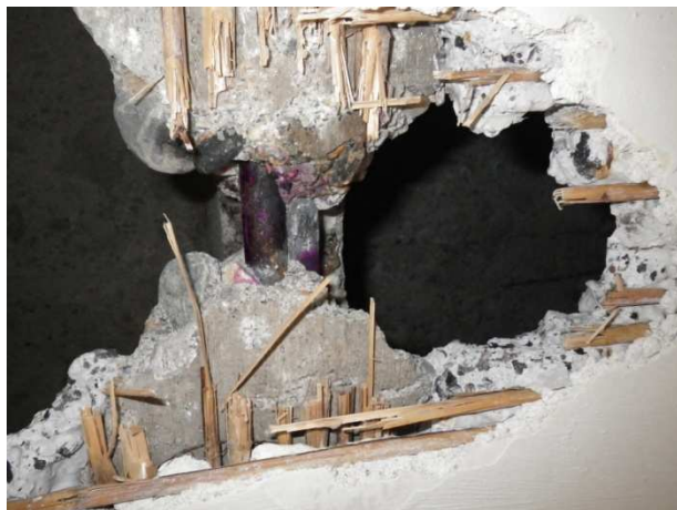
Foto č. 8 - 10 - sonda NV 7 – žebírkový strop, na snímcích patrná výztuž žebírka, rozšíření spodní pásnice žebírka, armování lehčeného betonu rákosovým pletivem a tvar dutiny stropu
