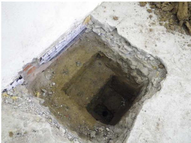
Foto č. 14 – 15 – kopaná sonda K 1 – patrný tvar základu, detail skladby podlahy
