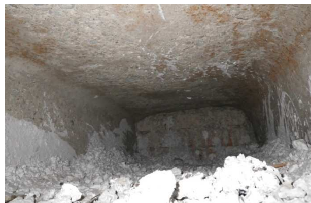
Foto č. 5 - 7 - sonda NV 5 – žebírkový strop, na snímcích patrná výztuž žebírka, rozšíření spodní pásnice žebírka, armování lehčeného betonu rákosovým pletivem a tvar dutiny stropu
