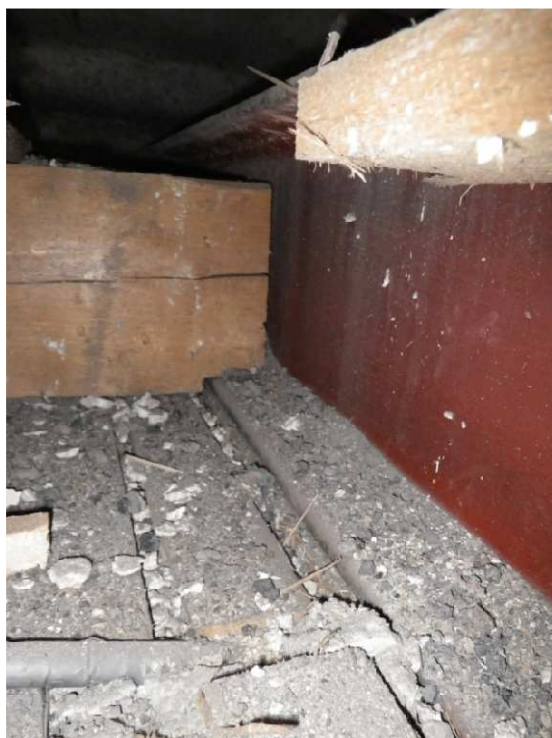
Foto č. 11 - 13 - sonda NV 13 – dřevěný trámový strop do I nosníků, na snímcích patrný I nosník opatřený ochranným nátěrem, na spodní pásnici uložen na výřez dřevěný trám, dutina mezi stropními trámy
